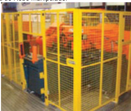
Foto 3 - Grade de proteção com barreira de luz em volta de Robô manipulador
