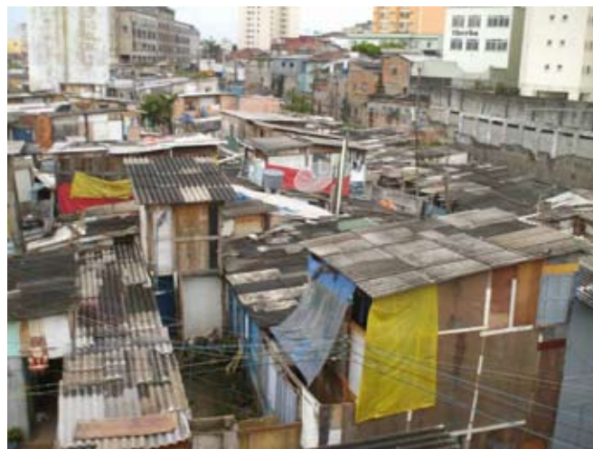
Insalubridade e instalações precárias.
