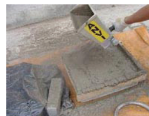
Figura 2: Projeção da argamassa sobre a base o substrato
