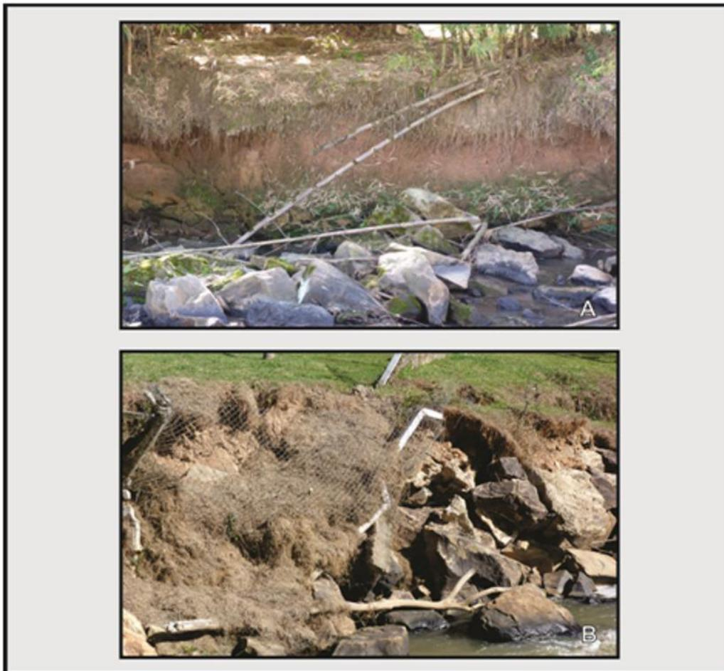
**Figura 4:** A – Erosão das margens do Camanducaia; B – Erosão das margens, solapamento, presença de blocos de concreto e cerca sobre o leito do Rio Camanducaia, local de captação de água do município.
