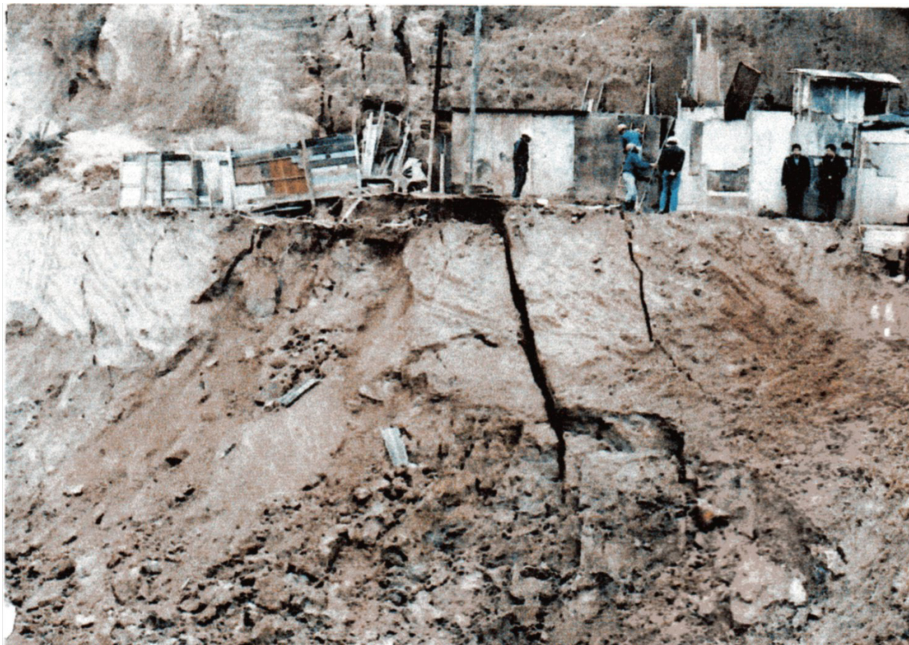
Figura 5: Movimentação de blocos de saprolito de gnaiss condicionada por descontinuidades estruturais reliquias, Parque Araribá, zona sul da Cidade de São Paulo (PELOGGIA, 1997b).
