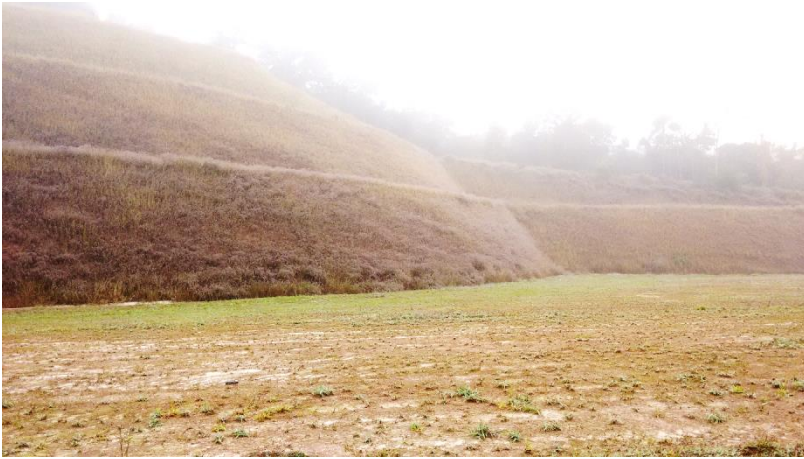
Figura 7 - Implantação de talude com níveis múltiplos, utilizado na prevenção de movimentação de massas, constatação no Trecho Leste do Rodoanel ( 23^{\circ}27'13.26''S / 46^{\circ}20'57.54''O )
