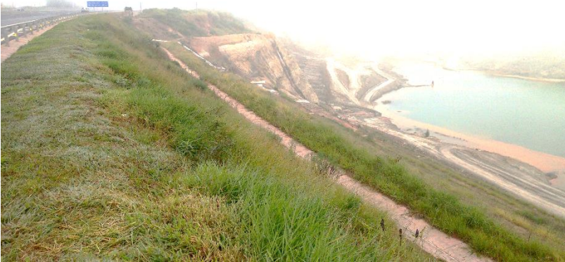
Figura 9 - Implantação de talude com sistema de drenagem para a contenção com alto risco de escorregamentos, constatação no Trecho Leste do Rodoanel ( 23^{\circ}28'11.36''S / 46^{\circ}19'59.78''O )
