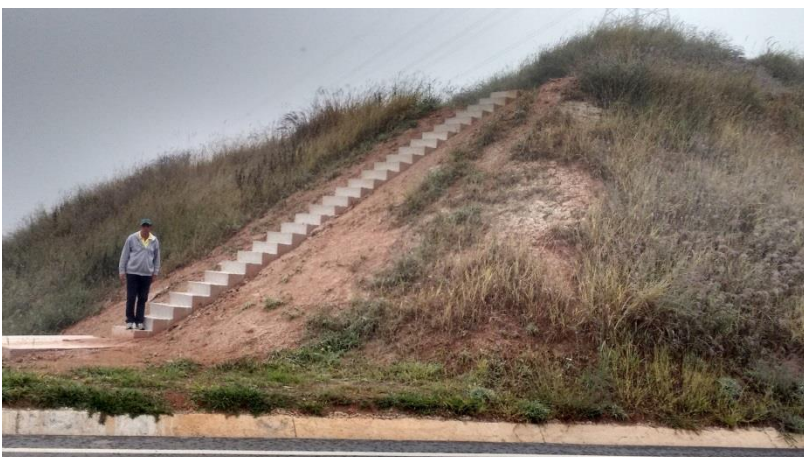
Figura 8 - Implantação de talude com sementeira de gramíneas, utilizado na prevenção de movimentação de massas, constatação no Trecho Leste do Rodoanel ( 23^{\circ}27'37.18''S / 46^{\circ}20'56.41''O )
