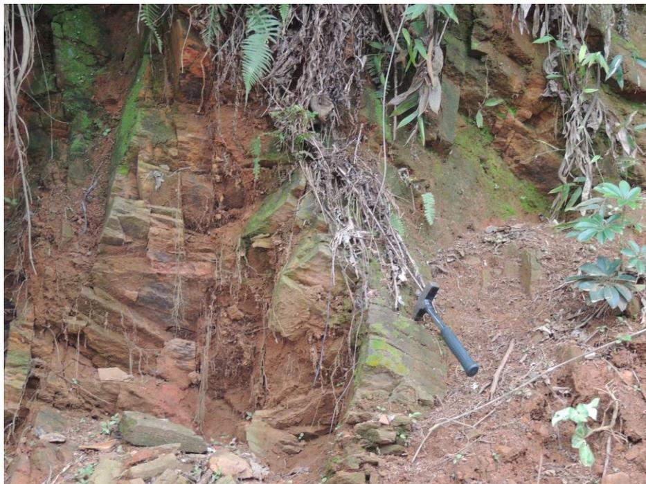
**Figura 11.** Talude de corte em saprolito mostrando condição geotecnicamente estável devido ao arranjo favorável das estruturas reliquiárias.
