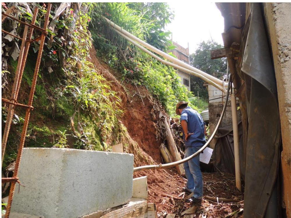
**Figura 8.** Corte na encosta expondo a cobertura remobilizada tecnogênica sobre solo superficial e solo de alteração de rocha.
