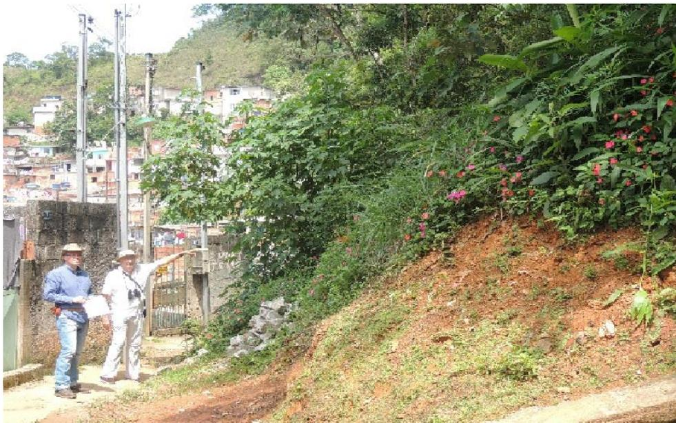
**Figura 10.** Em primeiro plano, massa escorregada resultante de movimento de massa induzido por corte na base da encosta.
