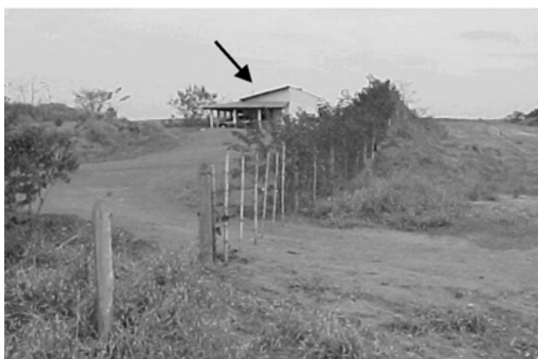
FOTO 3: Pilha de bota-fora classificada como camada construída do tipo espólico. Notar casa instalada no alto do bota-fora. Foto: J. E. Zaine, 2004. PICTURE 3: Stack of refuse mining area classified as spolian type. Note house on the top of the stack. Author: J. E. Zaine, 2004.
